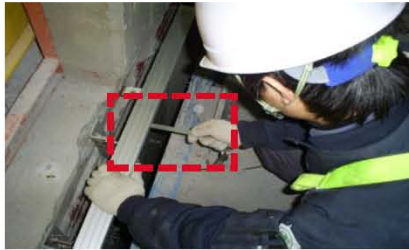
승강장 SILL 설치 (기준선 이격거리 30mm이내)
